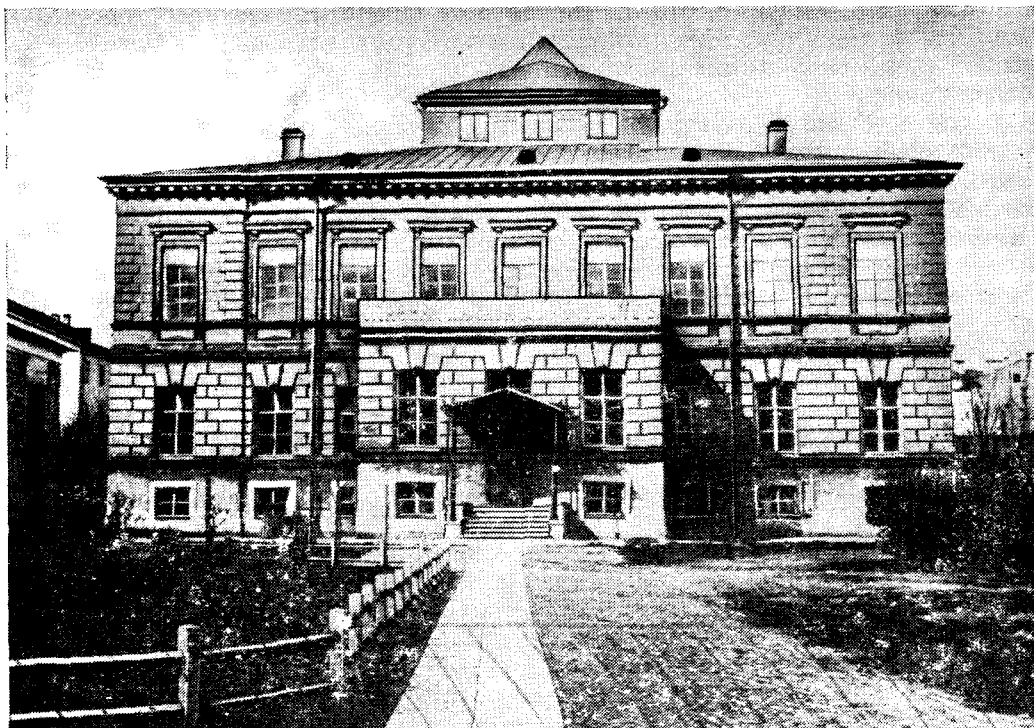
Первоначальный вид здания Главной палаты мер и весов.
